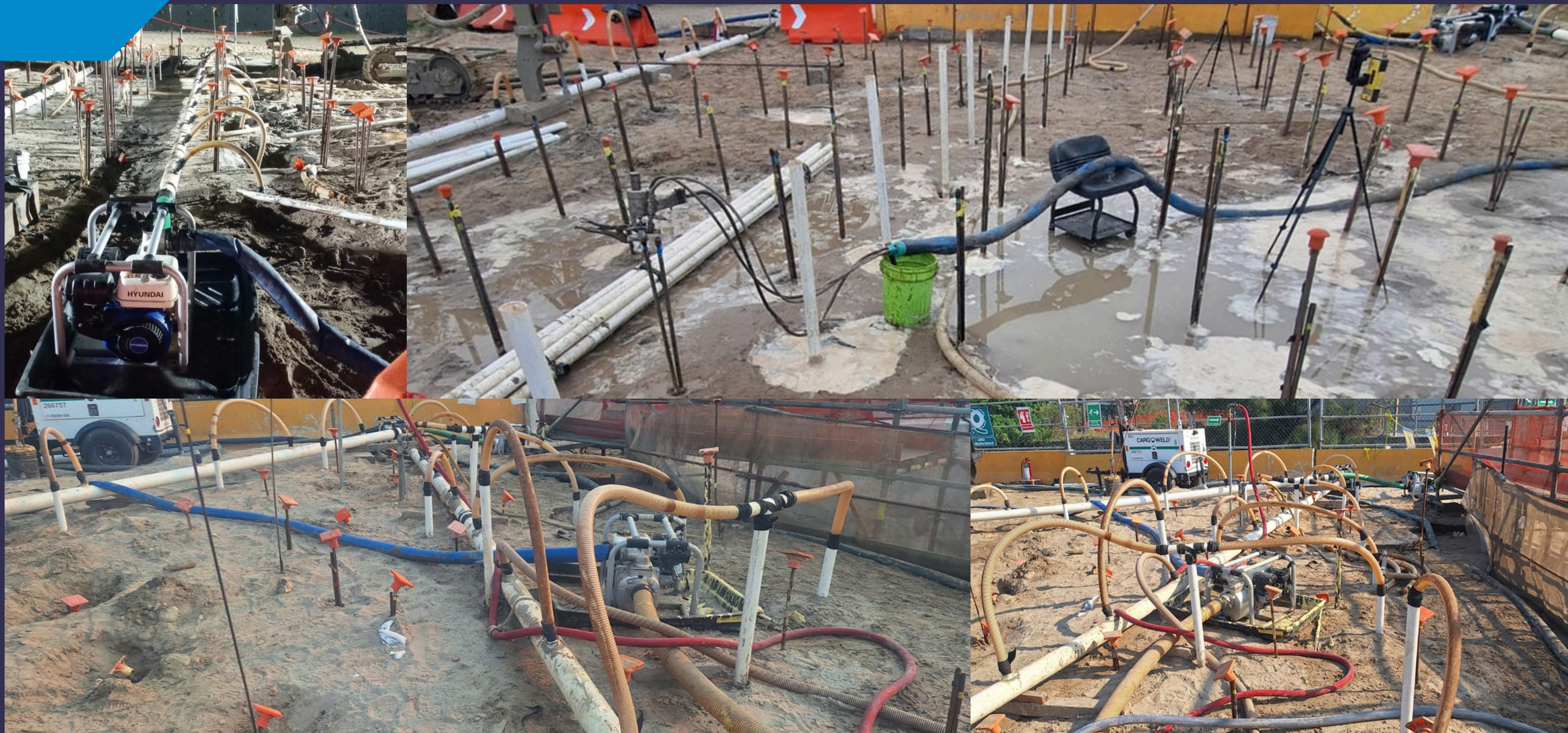
Abatimiento de N.A.F. con sistema wellpoint como servicio complementario a la inyección de polímero para estabilización de suelo a cargo de la empresa INTEC
